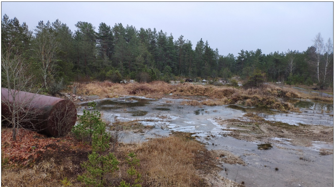
Foto 2 Reostunud pinnas on eemaldatud, jäänud on reostunud alade vahelised puhta pinnasega vallid.
