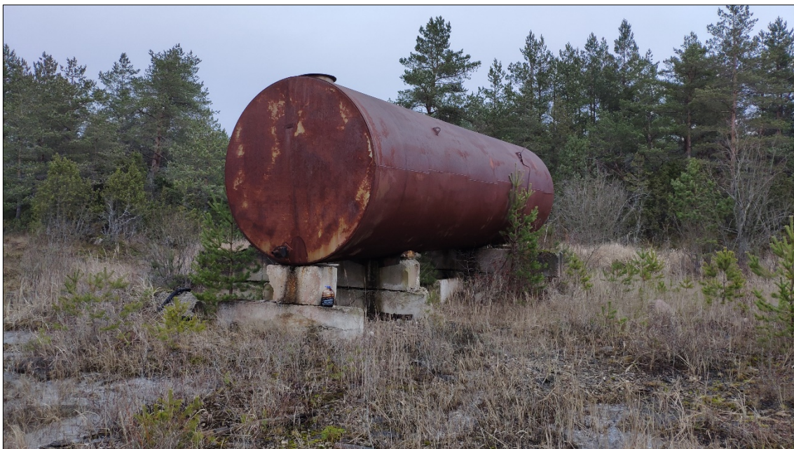
Foto 3 Kütusejääkidega mahuti. Kütust on püütud välja lasta. Plastnõu tünni jalase kõrval on potentsiaalne reostusallikas.
